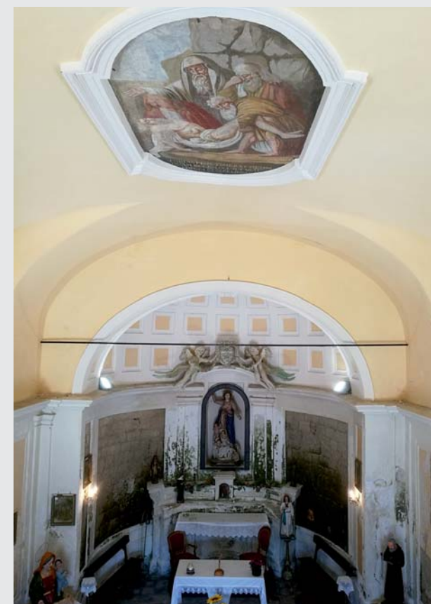
interno della Chiesa
